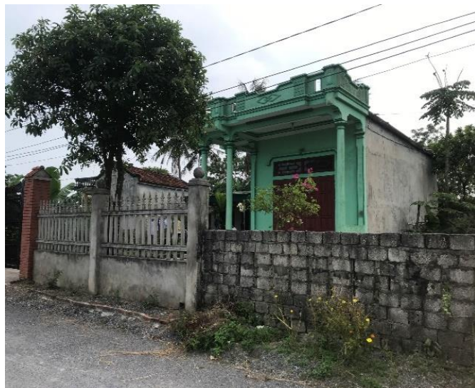
Hiện trạng nhà dân trong ranh giới dự án Tuyến đường phía Đông dự án
